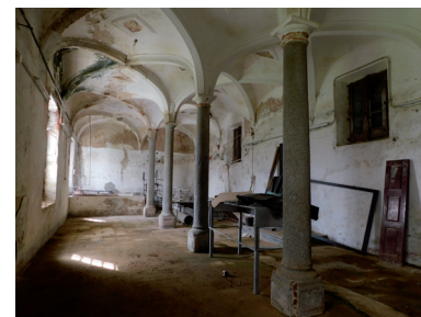
Fig. 46 - Antigo refeitório conventual, 2024. © Filomena Ribeiro.
