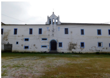
Fig. 1 - Fachada do Convento de Nossa Senhora da Saudação, 2013. © CMMN.
